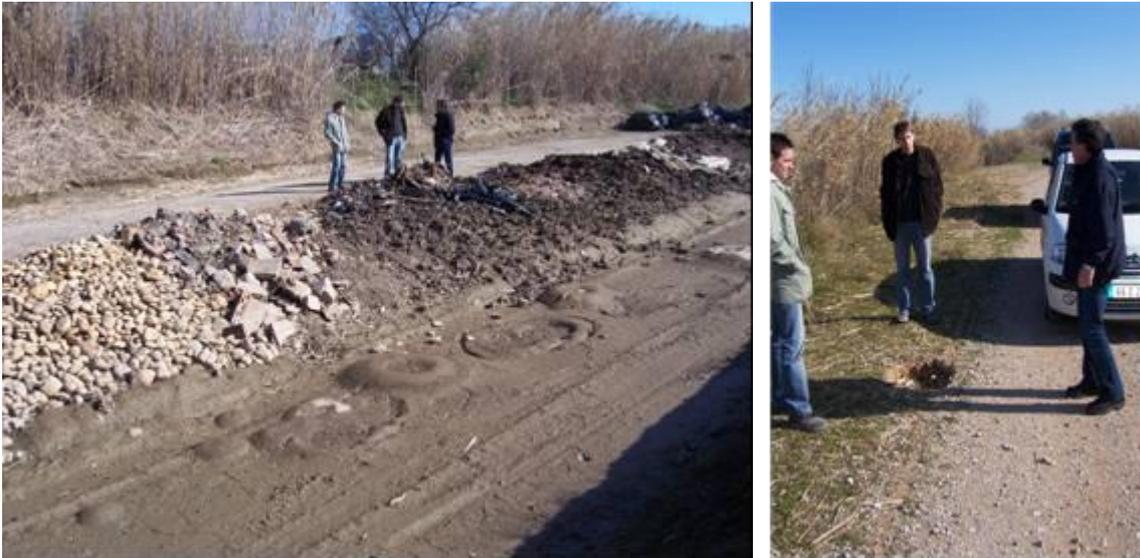
**Figures 1** : Photos d'indices d'érosion interne prises au cours d'une tournée de surveillance post-crue : 1a (à gauche) Sand-boils (volcans de sable) / 1b (à droite) Fontis en crête de digue.
