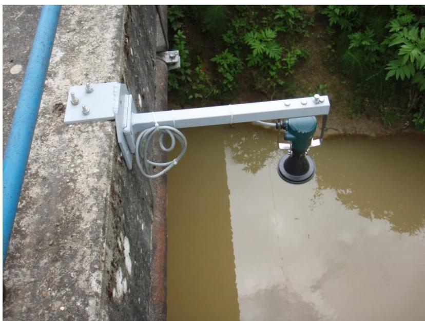
*Capteur de niveau d'eau par mesure radar, (photographie N. Watrin DREAL Midi-Pyrénées).*
