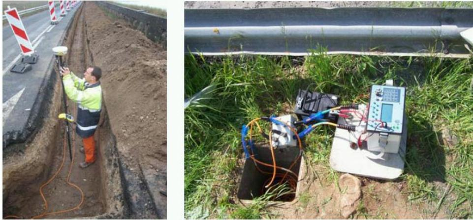
*Travaux d'instrumentation d'une digue existante le long de la Loire. Les électrodes sont installées en tranchée (à gauche) et localisées par GPS. A droite, le système d'acquisition. D'après Palma-Lopes, 2010.*
