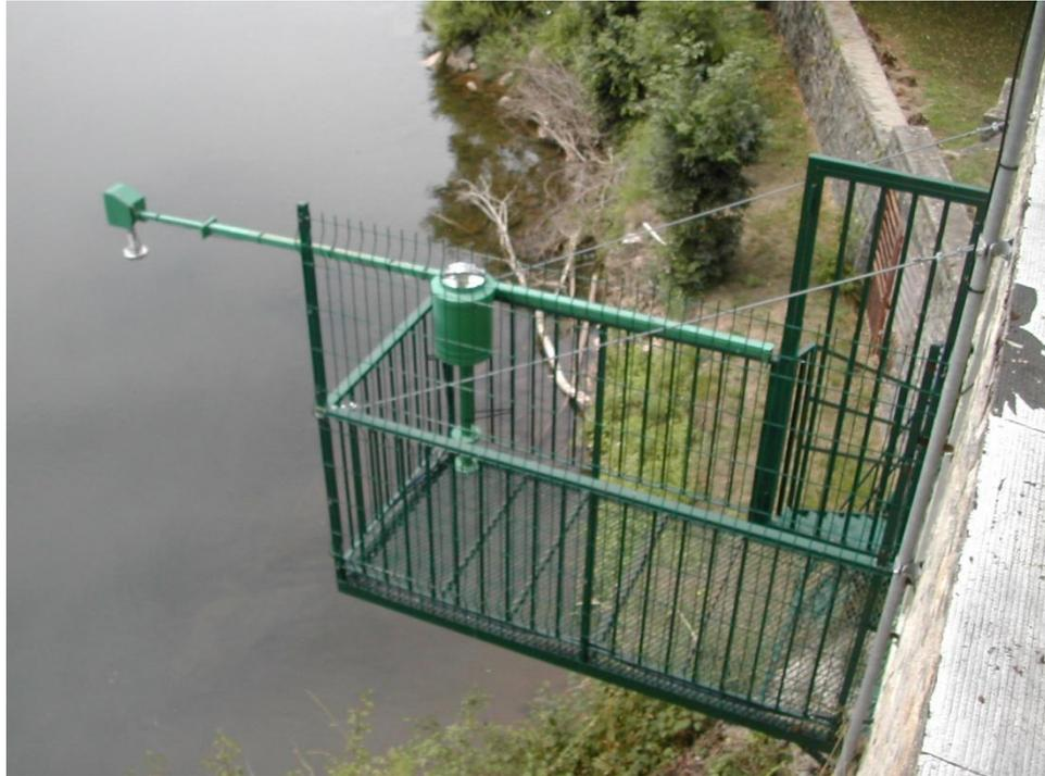
*Capteur radar implanté sur un bâtiment existant. Un escalier d'accès et des protections contre le vandalisme ont été installés (photographie N. Watrin DREAL Midi-Pyrénées).*
