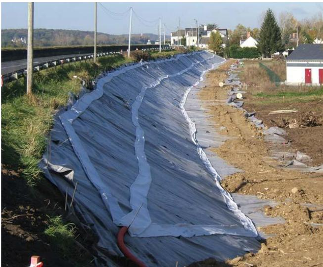
**Photo 2** : vue du talus aval avec le géotextile filtre et les trois lignes de fibres protégées par des bandes de géotextile.
